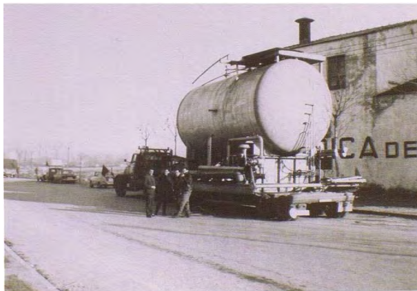
Figura 37. Detalle de las instalaciones del campo de Ayoluengo. Fotografías del separador de gotas, a la izquierda cuando era transportado hasta el campo en los años 60 (Ayala et al, 2006) y a la derecha en la actualidad.
