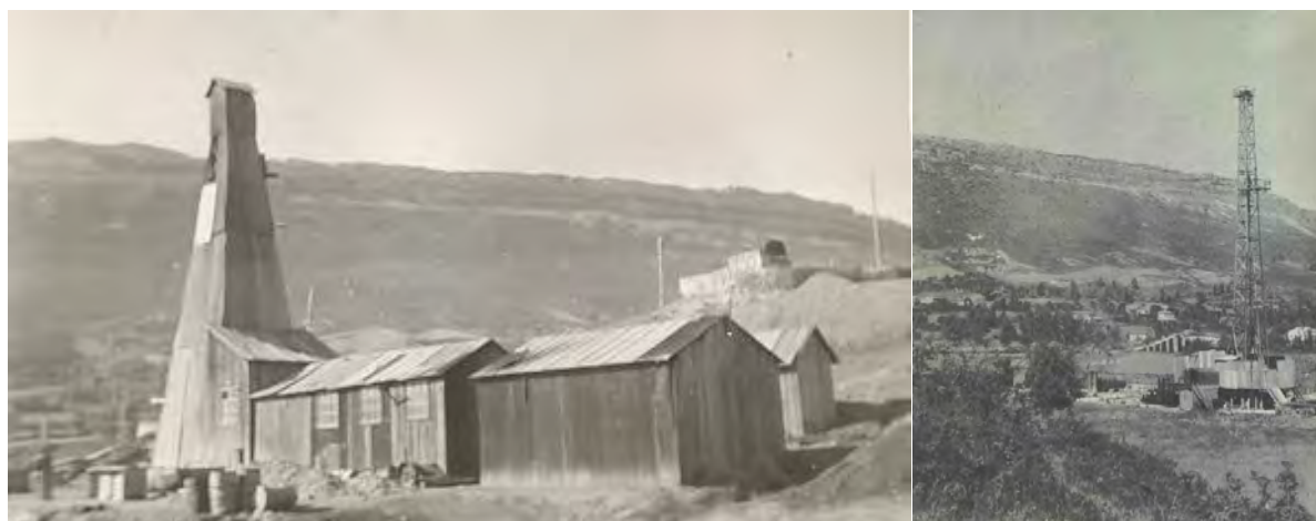
Figura 22. Fotografías de los pozos de exploración perforados por CAMPSA en Villanueva de Rampalay (Burgos), en el núcleo del anticlinal de Zamanzas. La foto de la izquierda fue tomada el domingo 3 de Noviembre de 1946, durante una visita al área por A. Almela, J.M. Ríos y V. Jones, todos ellos trabajando para CIEPSA 41 . La foto de la derecha corresponde al “Sondeo nº7” perforado a principios de los años 50 con la sonda Oil Well 64-B, adquirida por CAMPSA en el año 1947. Este produjo pequeñas cantidades de gas y petróleo, pero con un rápido declino de la presión. Fue el más profundo perforado por CAMPSA en esta zona, llegó hasta los 2177 metros de profundidad y terminó en rocas evaporíticas del Triásico Superior (Keuper). En ambas fotos, se observa al fondo las calizas del Cretácico Superior aflorando en el flanco occidental del anticlinal de Zamanzas.
