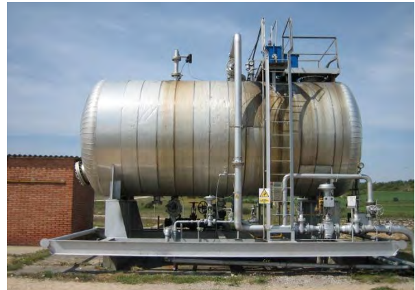
Figura 37. Detalle de las instalaciones del campo de Ayoluengo. Fotografías del separador de gotas, a la izquierda cuando era transportado hasta el campo en los años 60 (Ayala et al, 2006) y a la derecha en la actualidad.
